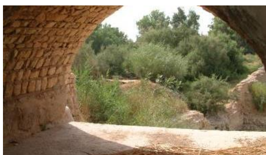
تصویر ۱۸- استفاده از سنگ‌های بزرگ تراش خورده در پایه تاق جهت جلوگیری از آب بردگی. منبع: (نگارنده)
