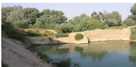
تصویر ۱۵- دیوار حفاظتی پایین‌دست بند و حوضچه آرامش. منبع: (نگارنده)
