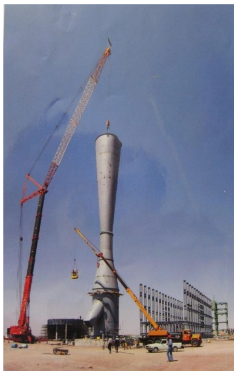
شکل ۱- جت اجکتور مادون صوت برای تخلیه گازهای حاصل از محصولات احتراق کوره صنایع فولاد
