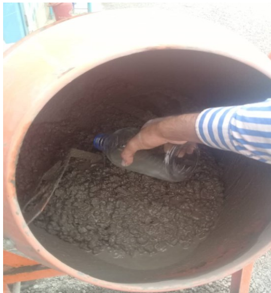
شکل ۵. افزودن محلول باکتریایی به مخلوط بتنی تازه
