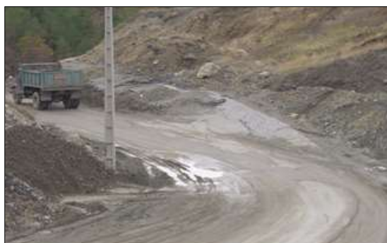
شکل ۹- بالآمدگی و کج‌شدگی جاده در محدوده لغزشی [۱۲].
