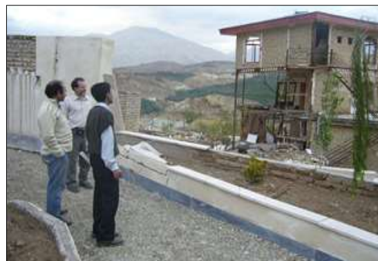
شکل ۱۱- تخریب ساختمان‌های مسکونی بر اثر لغزش در مرکز پهنه لغزشی [۱۲].
