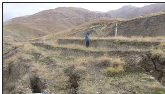
شکل ۷- نمونه‌هایی از پرتگاه‌ها و ترک‌های برشی مکرر در قسمت‌های مختلف زمین لغزش [۱۲].
