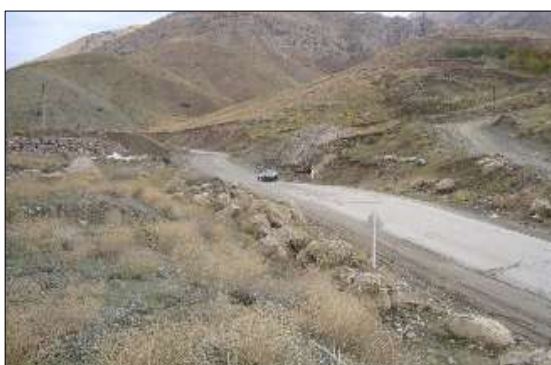
شکل ۱۰- بالآمدگی جاده در محدوده لغزشی [۱۲].
