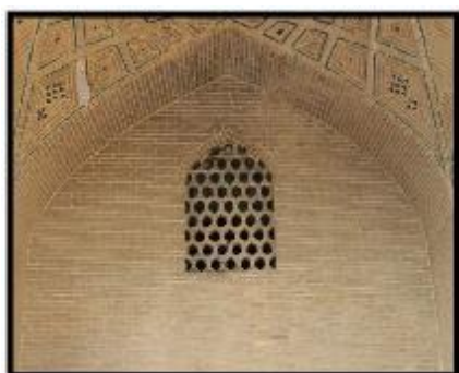
تصویر ۲- نمونه پنجره‌های مشبک آجری روی دیوارهای مسجد (منبع: نگارنده، ۱۳۹۸)
