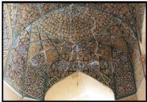
تصویر ۱۵- تکنیک تلفیق کاشی و آجر به کاررفته در رسمی‌بندی‌ها و دیوارهای سقف هشتی ورودی مسجد (منبع: نگارنده، ۱۳۹۸)
