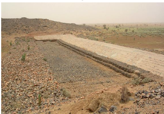
شکل ۳- سد مخزن ماسه ای پس از اتمام مراحل ساخت و ذخیره ی آب در آبرفت پشت آن
