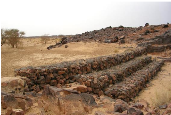
شکل ۲- ساخت سد مخزن ماسه ای و تشکیل آبرفت در پشت آن
