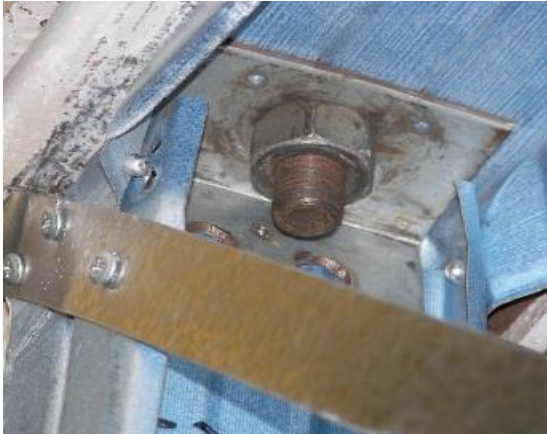
شکل ۱۲- نگه‌دارنده - محل اتصال عضو بالایی و عضو کناری
