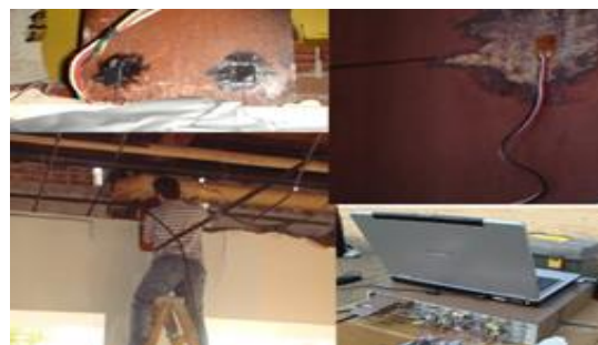
شکل ۹: نصب کرنش‌سنج روی ستون‌ها و تیرهای اطراف ستون‌های حذف شده [۲۶]
