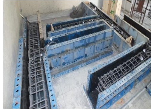
شکل ۴. قالب بندی سه نمونه اتصال ساخته شده
