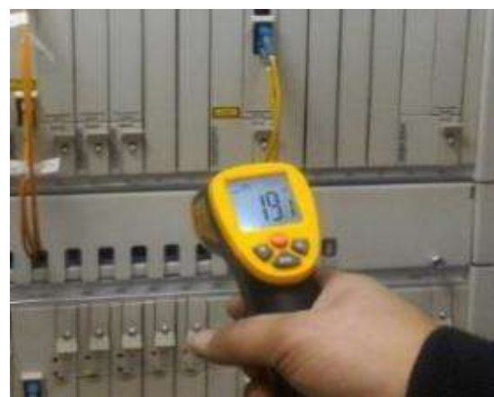
شکل ۴ - دمای اندازه‌گیری شده با دماسنج در ورودی به یکی از رک‌ها در ارتفاع ۱ متر از کف کاذب
