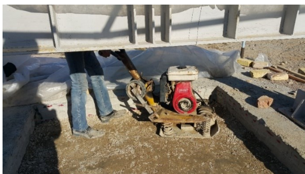
شکل ۵. کوبش لایه‌های سنگریزه‌ای در فرایند ساخت روسازی بتنی به مساحت ۴ متر مربع
