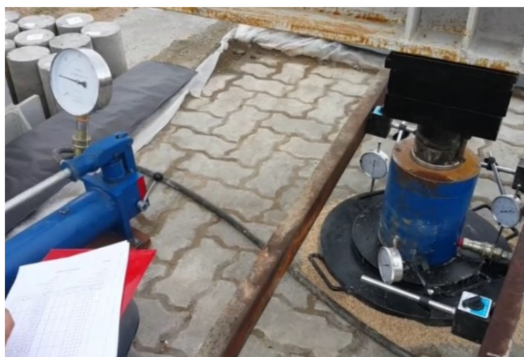
شکل ۸. نمایی از جک بارگذاری صفحه در وسط روسازی بلوکی بتنی فرودگاهی
