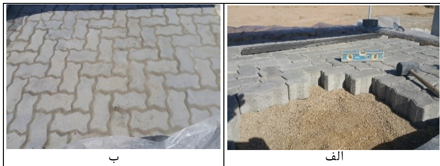
شکل ۷. اجرای بالشتک ماسه ای و بلوک کفپوش با چیدمان جناغ ماهی
