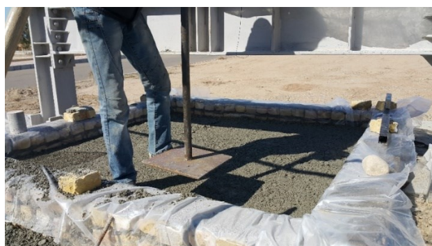
شکل ۶. اجرای لایه اساس سیمانی (CTB) زیر بلوک کفپوش
